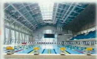
県営鈴鹿スポーツガーデン (水泳場)
